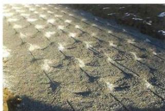
Eksempel på bygging av nytt infiltrasjonsanlegg.
