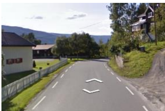
Figur 12: Dagens E16 har mange steder svært smal skulder og dårlig sikt i kurver.
