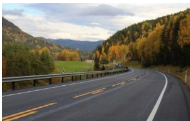
Figur 13: En vegbredde på 8,5m medfører asfaltert skulder på 0,75m.
