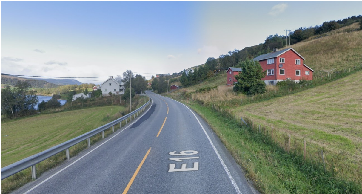
Figur 10: Bilde fra Ulnes som viser at en separat g/s-veg vil medføre innløsning av bebyggelse og betydelig beslag av dyrka mark.
