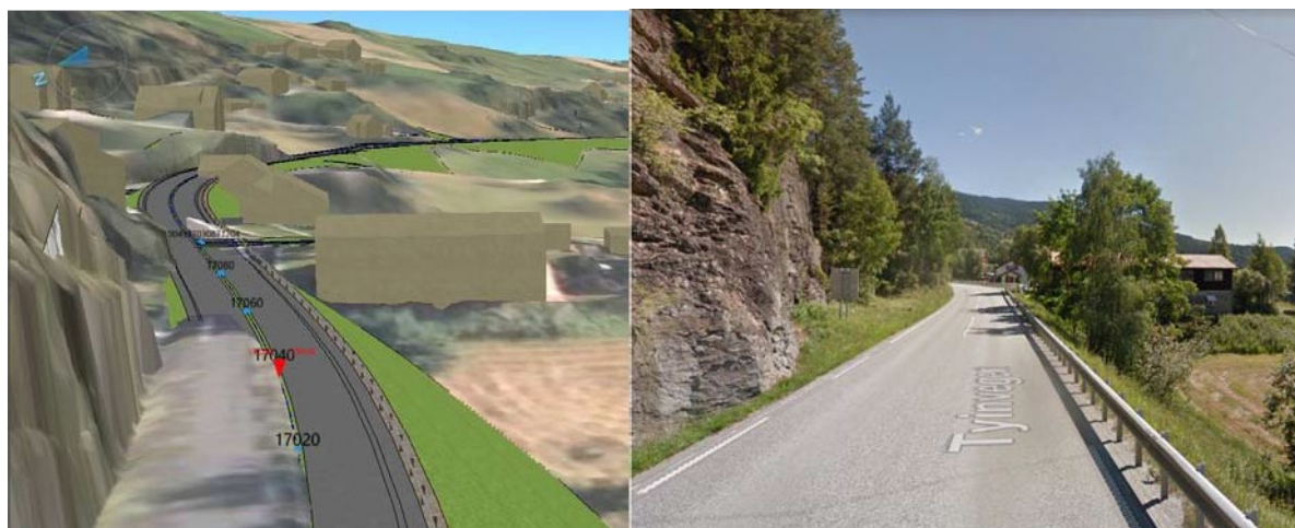
Figur 11: Eksempel fra Løkje hvor breddeutvidelse av E16 til 8,5m inkludert asfaltert skulder på 2 x 0,75m og utretting av kurver, vil medføre at E16 blir mindre uegnet for mjuke trafikanter.
