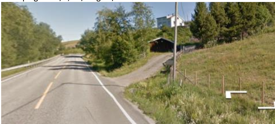
Figur 28: Dagens avkjøring til gnr. 39/29 har en uheldig utforming med tanke på stigningsforhold, vinkel inn mot E16 og siktforhold. Boligen på 39/29 ligger på en hylle på oversiden av E16.
